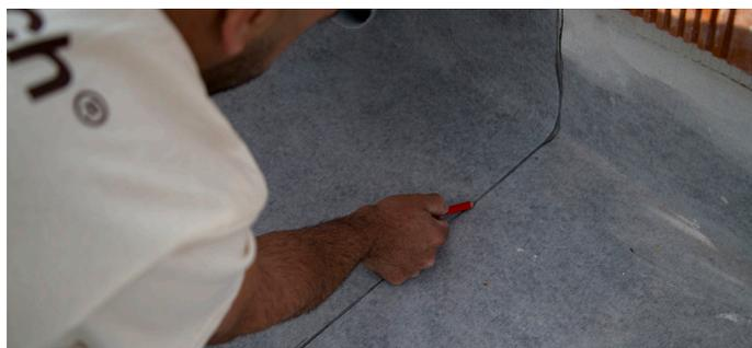
**4. Pegado de la lámina.** La elección del adhesivo con el que se fije la lámina dependerá del tipo de soporte y el tipo de cubierta que se desea impermeabilizar.
