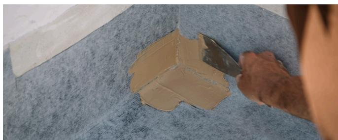
9. De la misma forma realizaremos el sellado de encuentros y esquinas. Recomendamos utilizar los refuerzos para esquinas interiores y exteriores **ECODRY CORNERIN** y **ECODRY CORNEROUT**. Así lograremos un sistema totalmente estanco.
