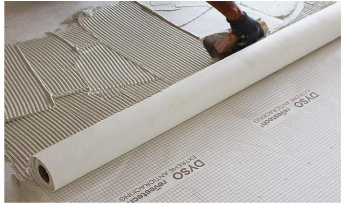
2. Aplicar cemento cola clase C2 S1/S2 con llana dentada de entre 4 y 6 mm. Aplicar el adhesivo en pequeños paños para evitar que se seque. En ningún caso instalar la lámina **DYSO** sobre un cemento cola semi fraguado.
