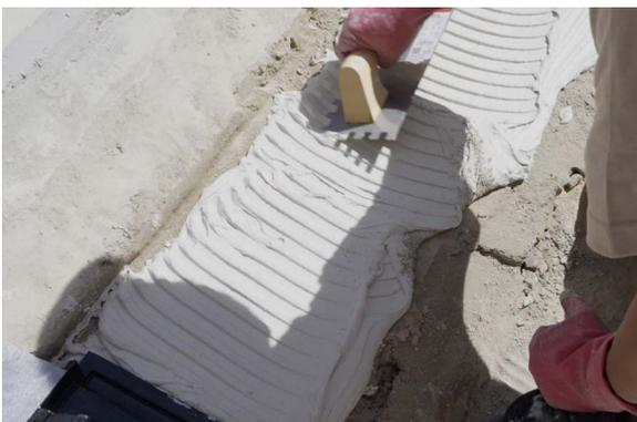
Adherir las piezas al soporte realizando un DOBLE ENCOLADO. Extender una capa fina de cemento cola C2 S1/S2 sobre el soporte y sobre el reverso de las piezas.
