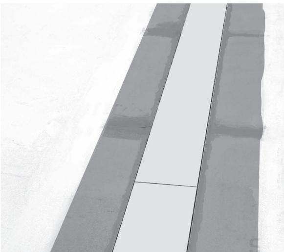
Para el revestimiento interior del canal cortar las piezas cerámicas del pavimento en función del diseño y medida del canal.
