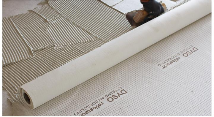
2. Aplicar cemento cola clase C2 S1/S2 con llana dentada de entre 4 y 6 mm. Aplicar el adhesivo en pequeños paños para evitar que se seque. En ningún caso instalar la lámina **DYSO** sobre un cemento cola semi fraguado.
