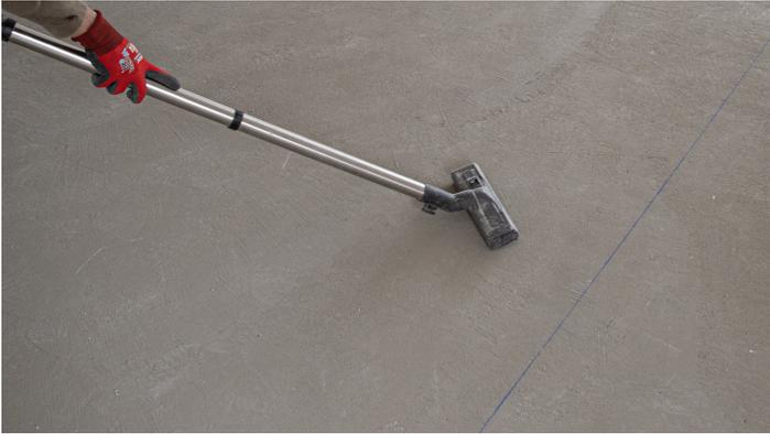
1. Comprobar la estabilidad del soporte y limpiar la superficie. El soporte no debe contener elementos que pudieran dificultar la adherencia de la lámina.
