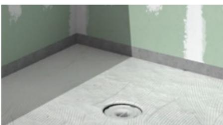
7. Una vez fraguado el mortero, aplicar sobre el mismo cemento cola clase C2; así como en el reverso del plato (doble encolado). Instalar.
