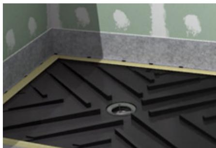
17. Para evitar manchar el plato, colocar cinta carrocera gruesa en todo el perímetro, desde los topes del plato hacia el interior. Pegar la banda **ECODRY BANDA 13x5** sobre los cuatro aleros del plato con adhesivo **REVESTTECHFLEX**. Pegar la banda **ECODRY BANDA 13x5** a los encuentros con suelos y paredes, usando cemento cola clase C2 S1/S2.
