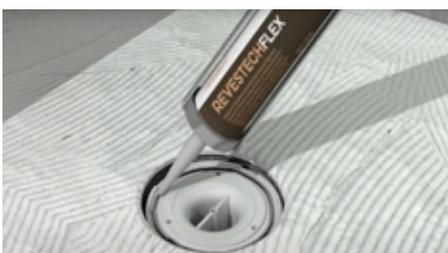
10. Crear cordón de **REVESTECHFLEX** a lo largo del perímetro de la parte superior de la cazoleta.
