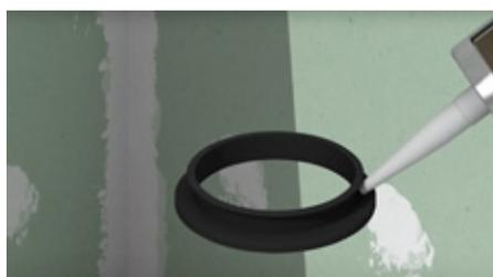
8. Crear un cordón de adhesivo **REVESTECHFLEX** en todo el interior de la junta tipo labial.
