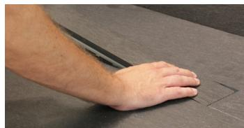
**1. Colocar la cuna del lineal sobre el sumidero y adherir a la lámina con cemento cola.**
