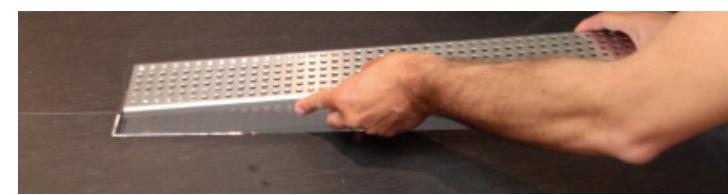
**6. Formar las esquinas plegando la lámina. Para una acabado perfecto utilizar las piezas premoldeadas DRY50 CORNER IN y DRY50 CORNER OUT.**
