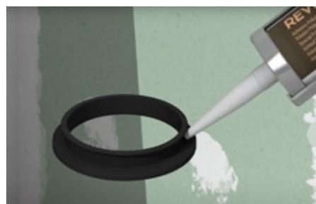
4. Crear un cordón de adhesivo **REVESTTECHFLEX** en todo el interior de la junta tipo labial.
