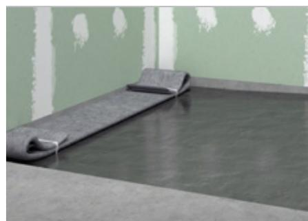
9. Realizar las pendientes. La parte plana del alero del **LINEAL/SUMI LEVEL** determina su punto de inicio.
